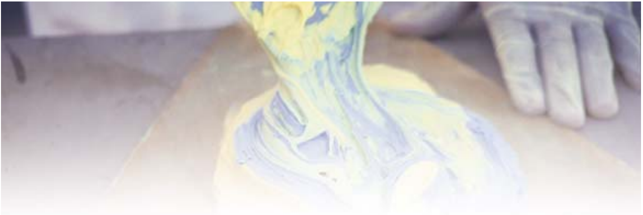
Mezcla de masilla epoxi
